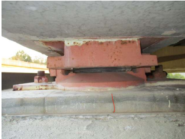
(P2 Sh6) 무수축물탈균열(0.3mm미만)
