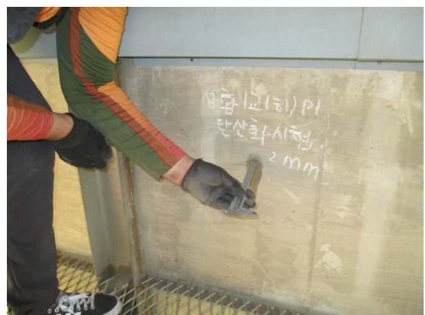
콘크리트 탄산화시험(탄산화 깊이측정)
