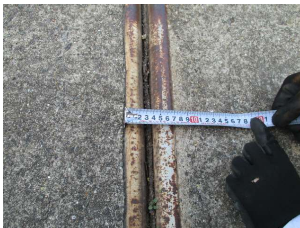
신축이음 유간거리 측정
