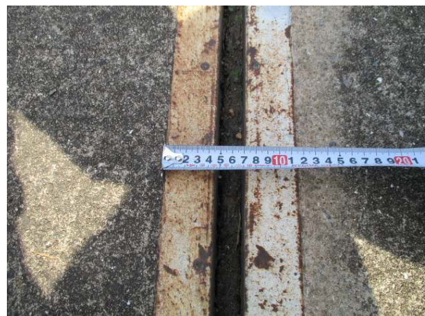
신축이음 유간거리 측정
